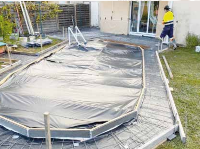
Contorno de piscina · Molde madera · Colro 147 Marfil · Desmoldante pardo
